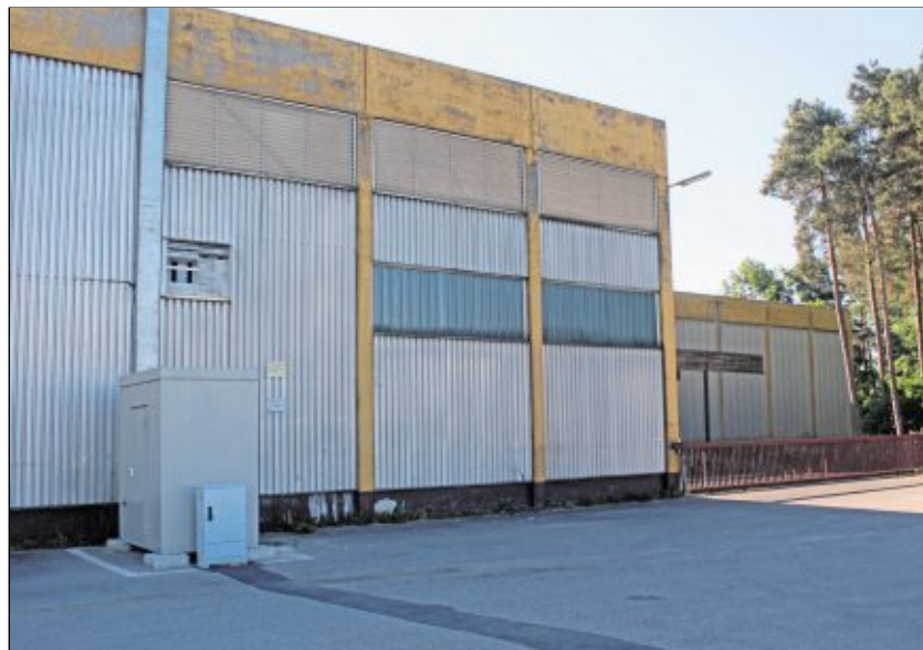
Die ehemalige Geflügelschlachterei an der Thanner Straße soll zum Wohnheim für Flüchtlinge umgebaut werden. Die Genehmigung dazu hat das Landratsamt unter Auflagen erteilt. Bild: Mayer
